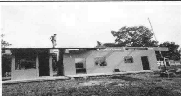
Foto 7: Instalación de lámina troquelada Aluzinc calibre 26.
