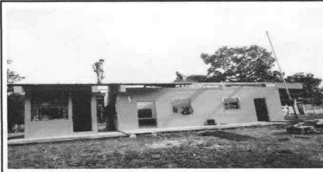
Foto 4: Sustitución de capotes de lámina para lámina troquelada Aluzinc calibre 26.
