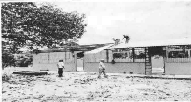
Foto 1: Sustitución de lámina, por lámina troquelada Aluzin calibre 26.
