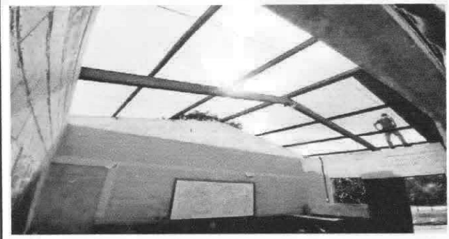
Foto 2: Mantenimiento de estructura de soporte de metal.
