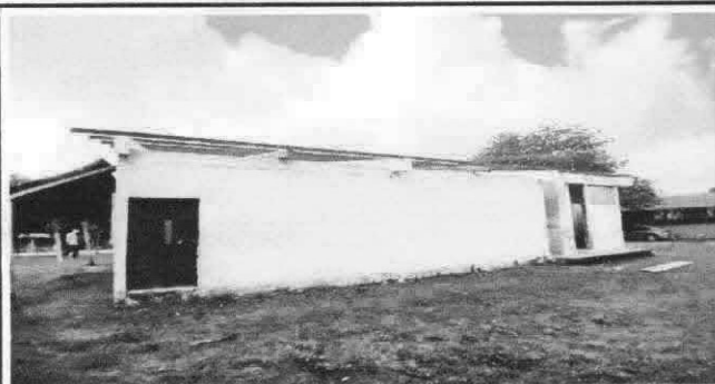
Foto 3: Sustitución de elementos de fijación.
